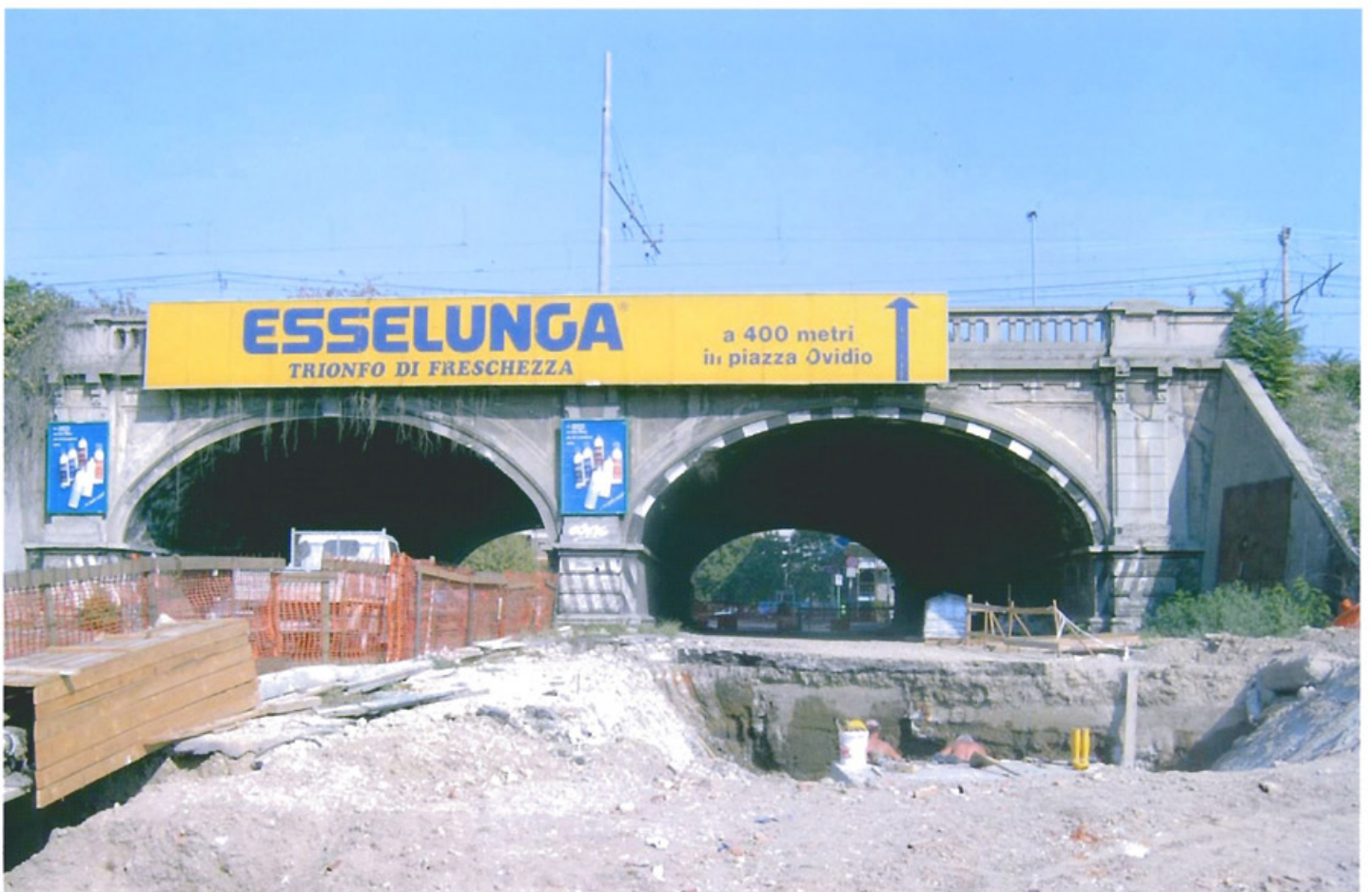
Inizio lavori di ampliamento e ricostruzione del ponte di Viale Lombroso a Milano.
