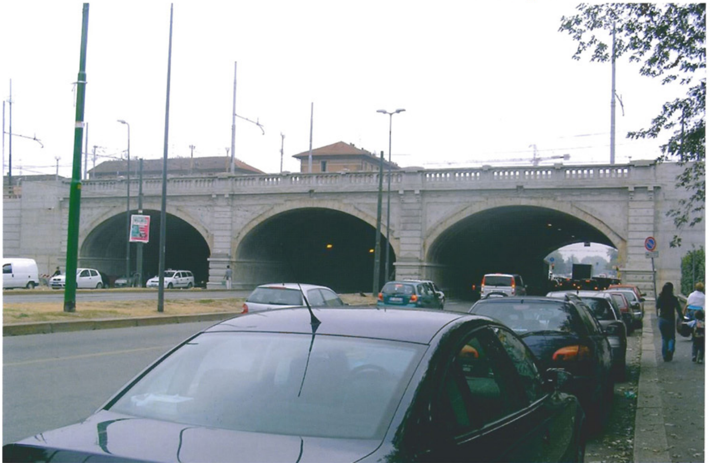
Ricostruzione del ponte di Viale Corsica a Milano.
